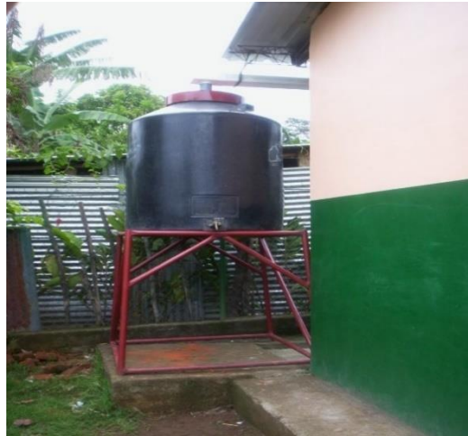
Figura 4. Techo de una escuela utilizado para captación de agua lluvia.
