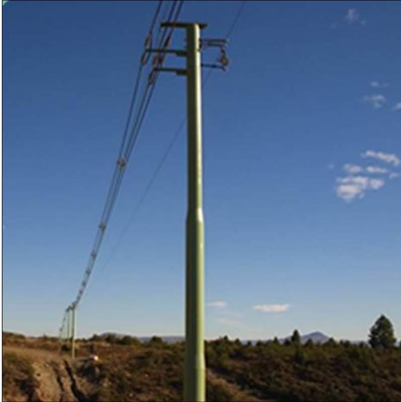
Figura 35. Tendidos de grandes vanos.
