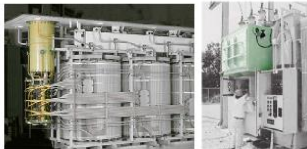
Figura 20. LTC de resistor a la izquierda (dentro del tanque) y LTC de reactor a la derecha (externo).
