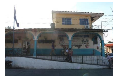
FOTO N°10: ACCESO A ENTRADA PRINCIPAL N°1 POR RAMPA. (2)
