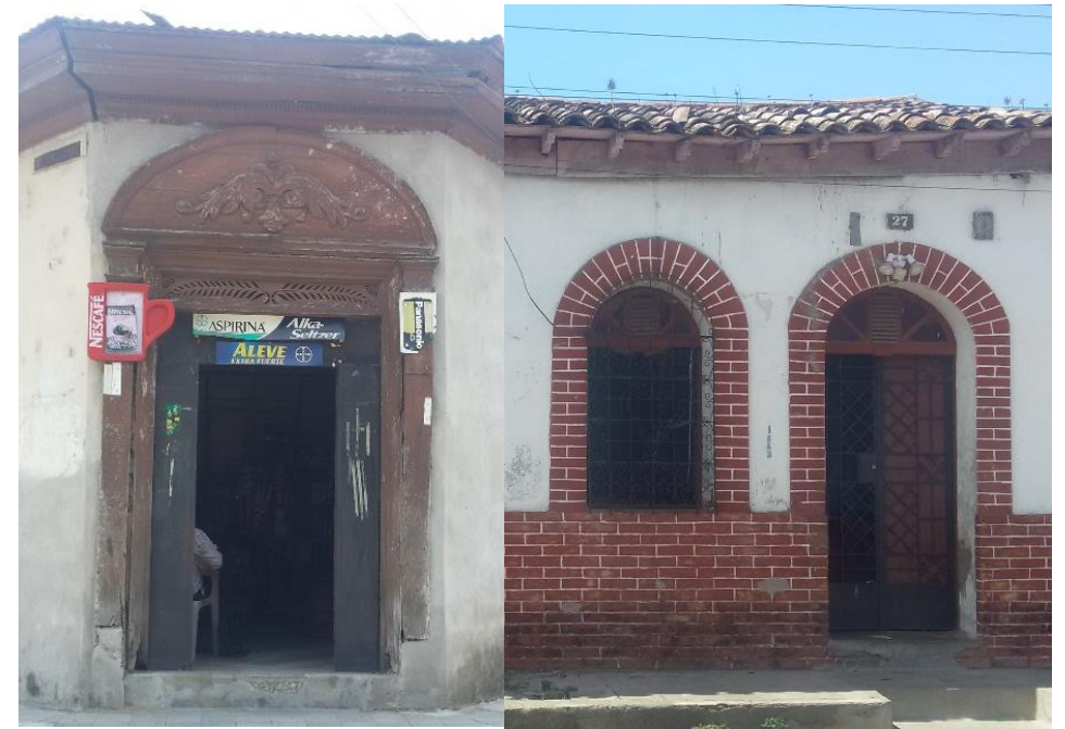
Foto MA-6: Detalles neo-renacentistas Fuente: Foto tomada por grupo de trabajo
