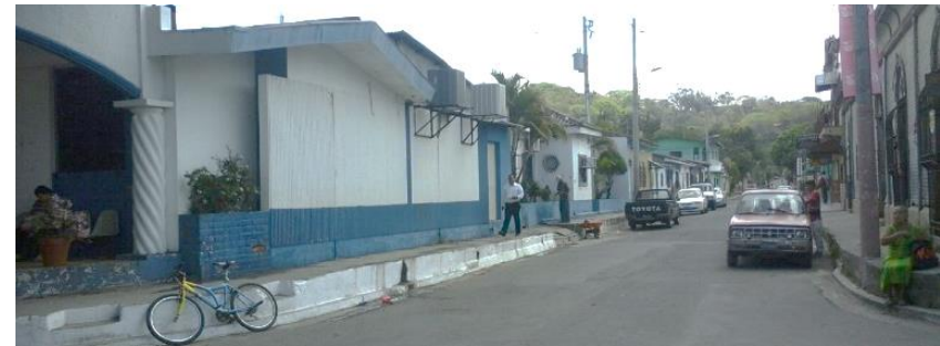
Foto MU-10: Alcaldía Municipal de Tonacatepeque Fuente: Foto tomada por grupo de trabajo
