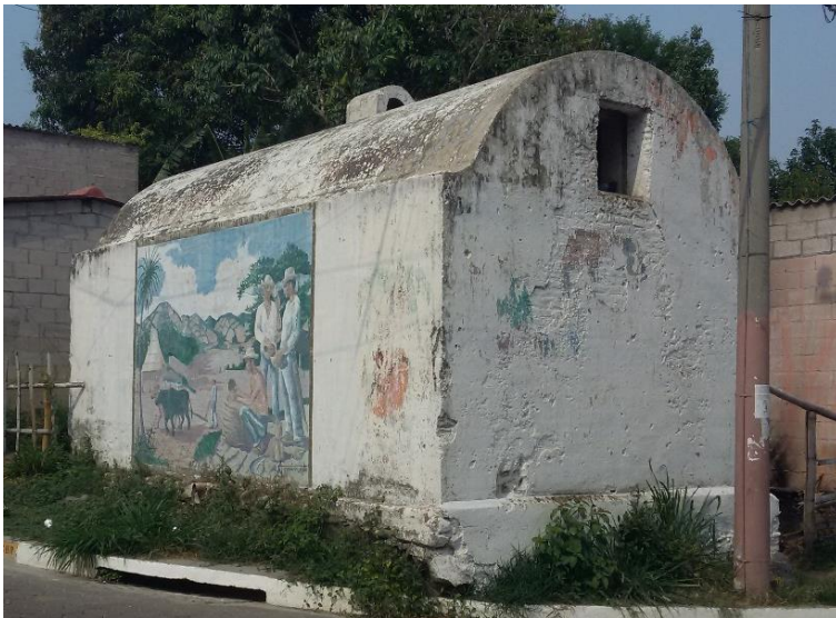
Foto MA-13: Antiguo tanque de agua Fuente: Foto tomada por grupo de trabajo
