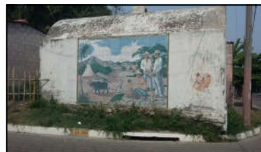
6. Antiguo Tanque de Agua
