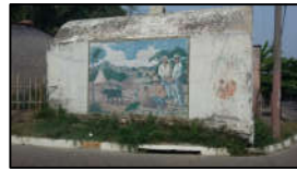
9. Antiguo Tanque de Agua
