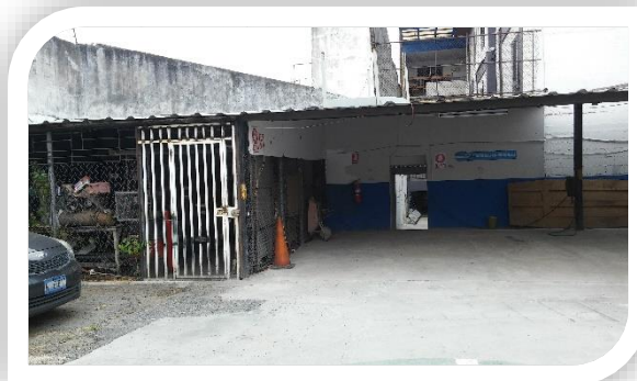
Imagen N°9: Acceso Vehicular y Caseta de Vigilancia
