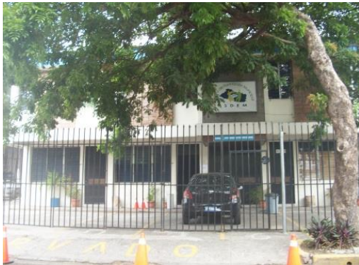
Imagen N° 33: Fachada Sur CFM
