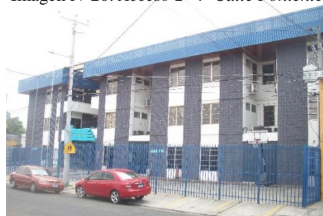
Imagen N°20: Acceso 2- 4ª Calle Poniente
