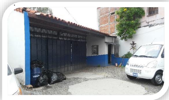
Imagen N°9: Acceso Vehicular y Caseta de Vigilancia
