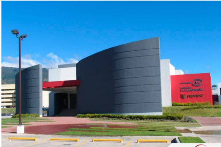
Imagen N° 38: Fachada Sur de auditorium
