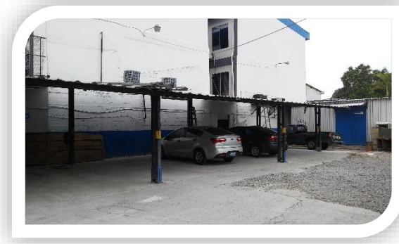
Imagen N°11: Estacionamiento Techado y archivo.
