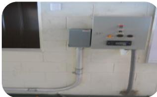
Caja térmica de control para la extracción del agua potable desde el pozo hasta el tanque de almacenamiento de agua potable.
