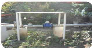
Sistema de cañería de tubo galvanizado que desde el pozo hasta el tanque de captación.
