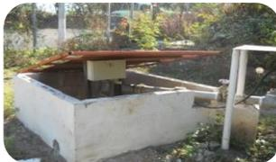
Pozo de extracción de agua potable, que es un sistema de perforación manejado desde una bomba eléctrica para enviar mediante cañería al tanque de captación.
