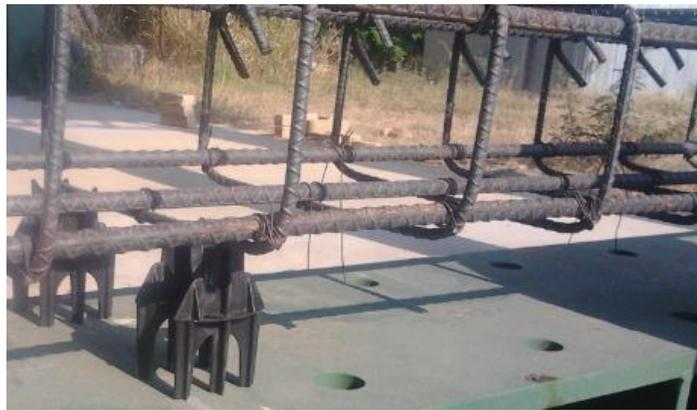
*Figura 3.8: Separadores plásticos para dar recubrimiento*
