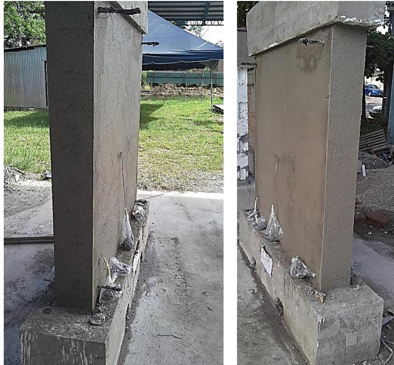
*Figura 5.26: Encamisado de pared con malla electro soldada*
