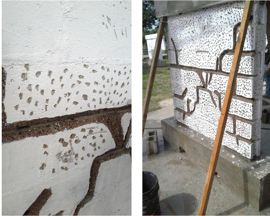
*Figura 5.16: Picado de grietas y formación de irregularidades en la superficie de la pared*
