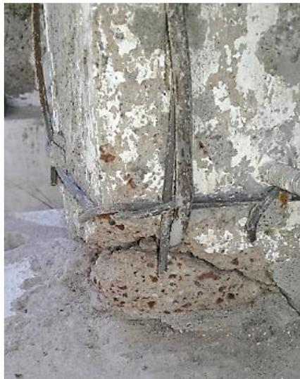
*Figura 5.43: Daños en la esquina inferior norte de la pared.*
