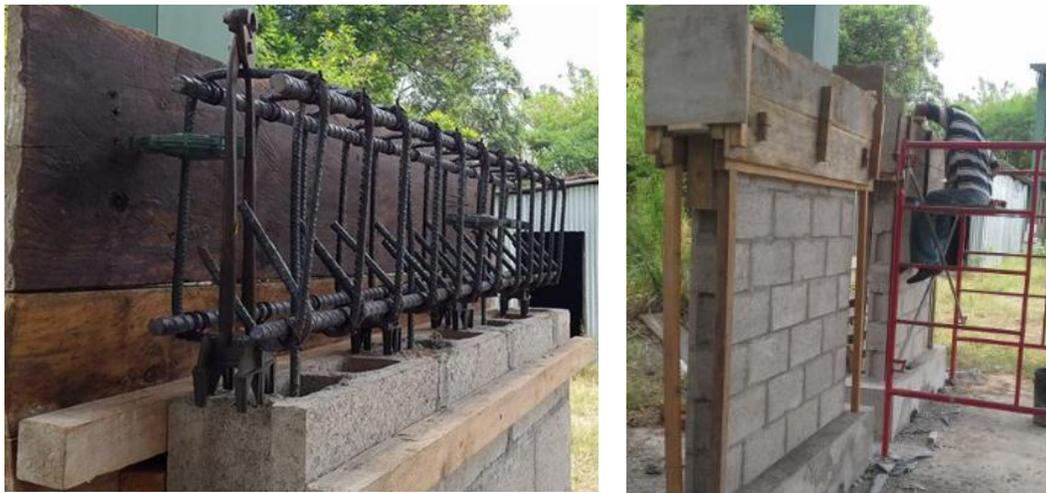
*Figura 3.16: Elaboración de encofrados de viga de transmisión de carga.*
