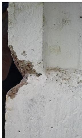
*Figura 5.4: Picado de grietas en forma de “v”*
