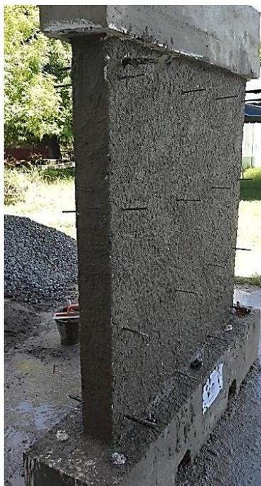
*Figura 5.21: Colocación de la primera capa de mortero*
