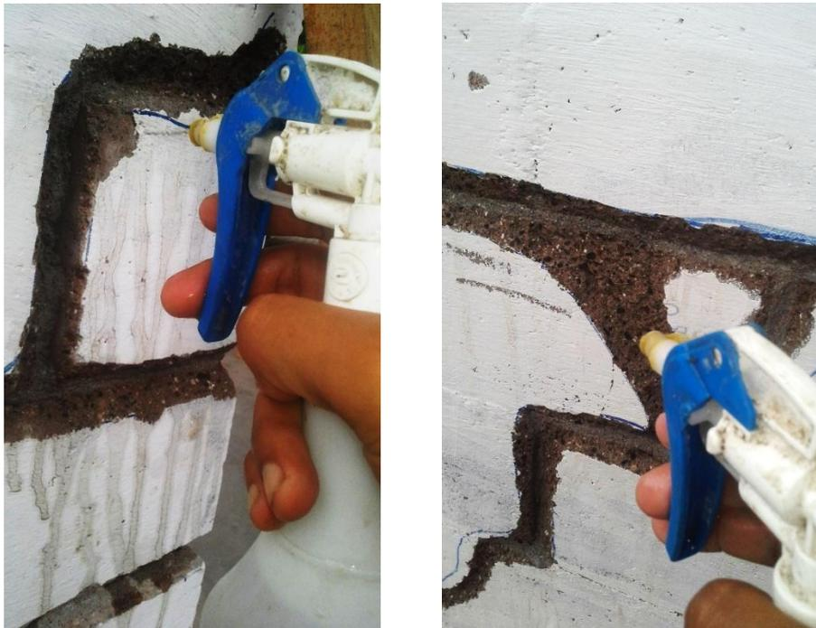
*Figura 5.9: lavado con agua y saturación se superficie a reparar*
