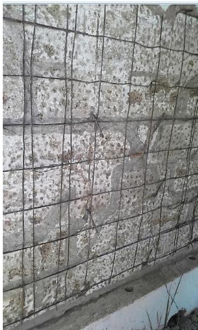
*Figura 5.40: Estado de daño final, pared BC-M02RF [Vista Este].*
