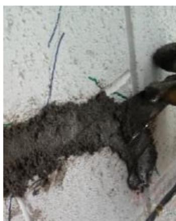
*Figura 5.13: colocación de material de relleno*
