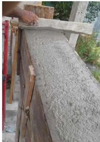
*Figura 3.17: Colado de viga de transmisión de carga.*
