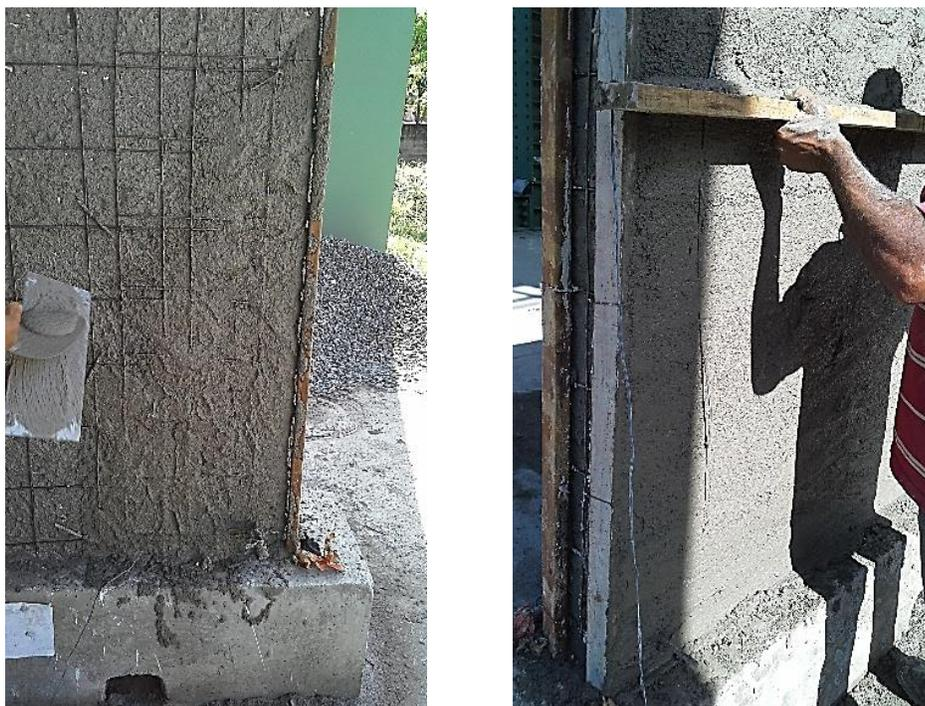
*Figura 5.24: Colocación de segunda capa de mortero*
