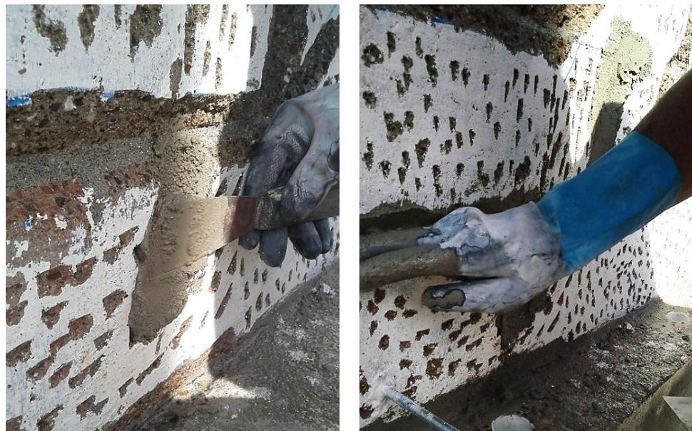
*Figura 5.17: Colocación de mortero de relleno*
