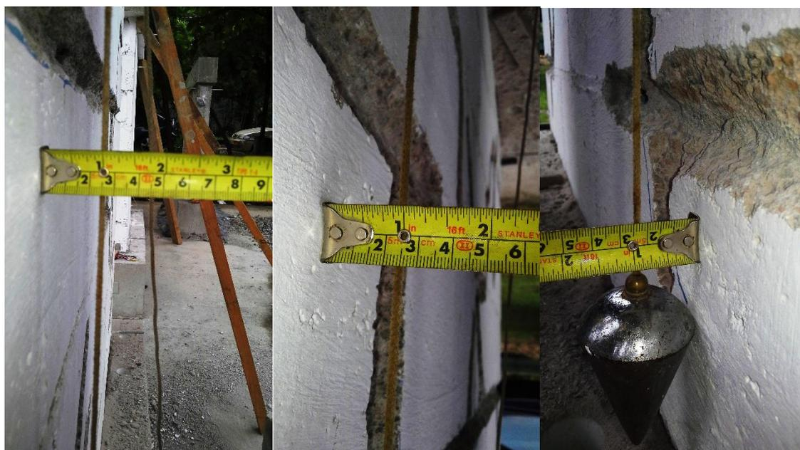
*Figura 5.10: Verificación de la verticalidad antes de colocar el puente de adherencia*
