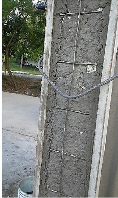
*Figura 5.25: Colocación de sargentos para sostener las cañuelas.*
