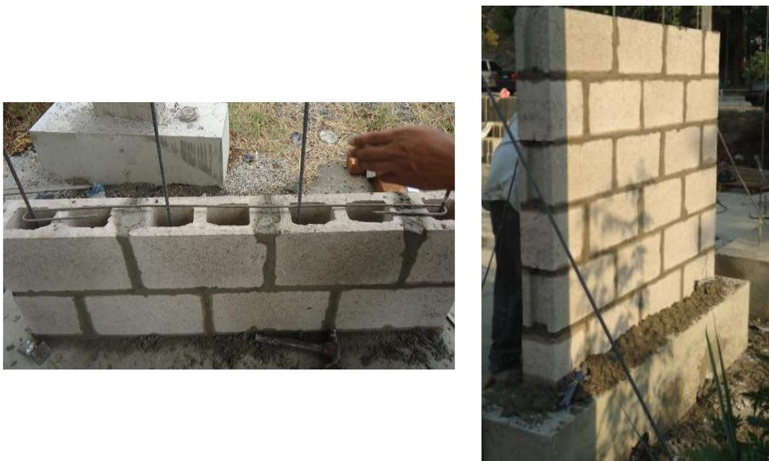
*Figura 3.14: Pegado de bloques de concreto.*
