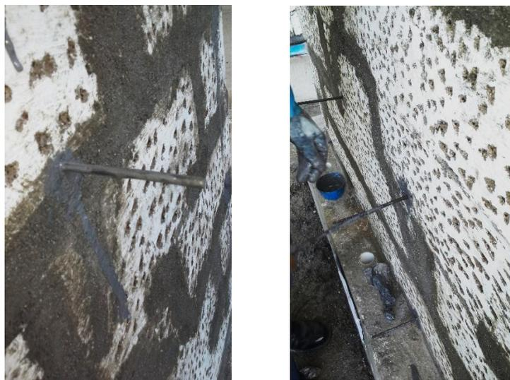
Figura 5.20: Colocación de anclajes
