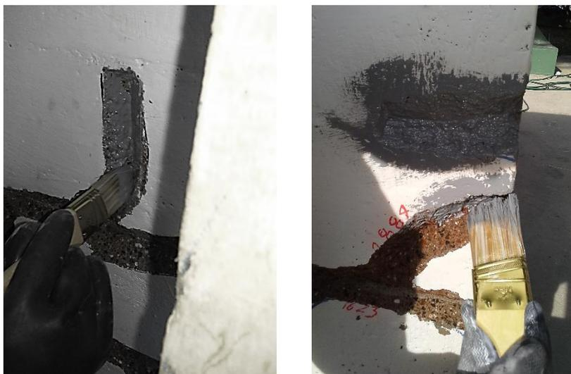
*Figura 5.11: Colocación del puente de adherencia*
