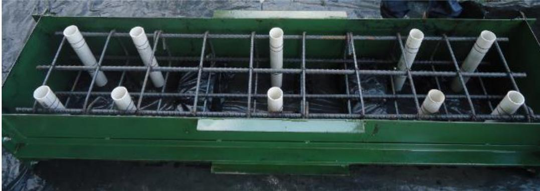
*Figura 3.7: Colocación acero de refuerzo.*
