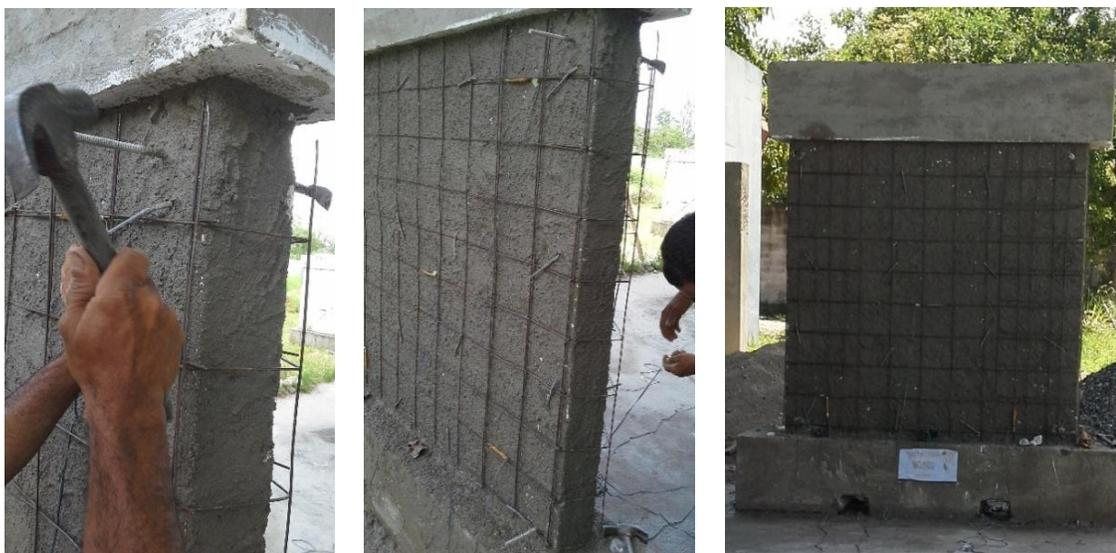
*Figura 5.22: Colocación de malla electro soldada.*
