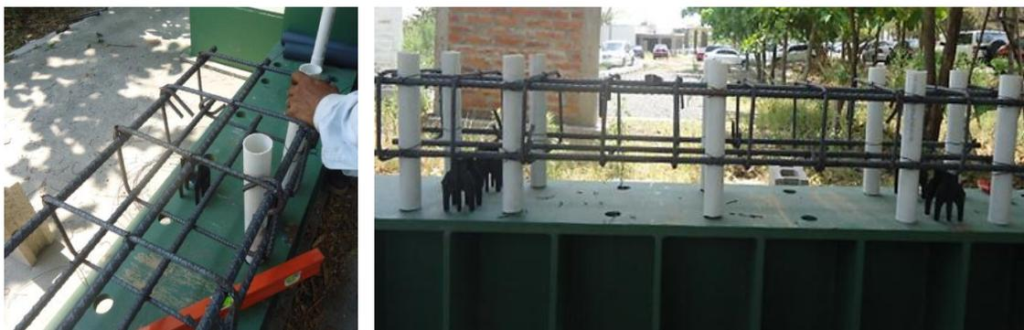
*Figura 3.5: fijación de tubos PVC con acero de refuerzo.*
