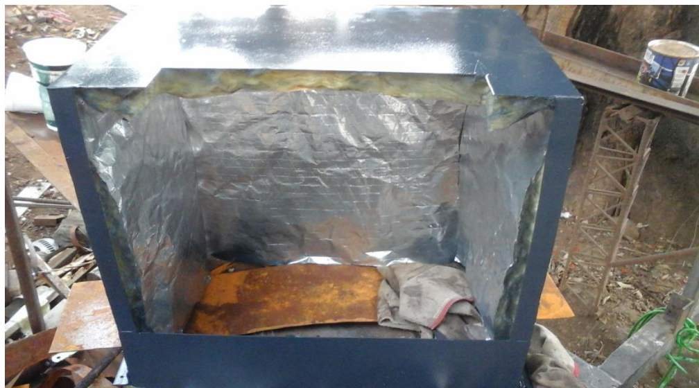
Figura 41. Colocación de fibra de vidrio en el interior de las tapaderas (Fuente propia).
