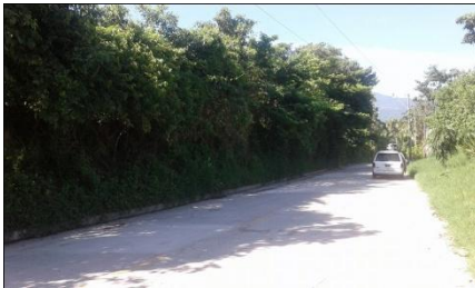
Imagen N° 17: Vista de tendido eléctrico sobre calle cuesta El garrobo Fuente: Fotografía tomada en el lugar en abril 2016
