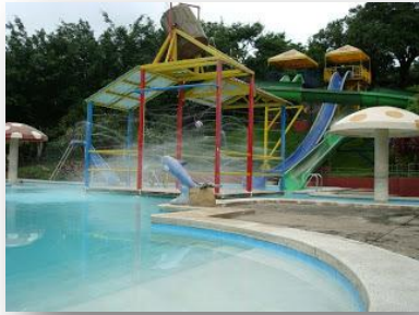
Imagen N° 7: Instalaciones del Polideportivo Vitoria Gasteiz, Nejapa Fuente: Infraestructura. Blog. Polideportivo Nejapa.
