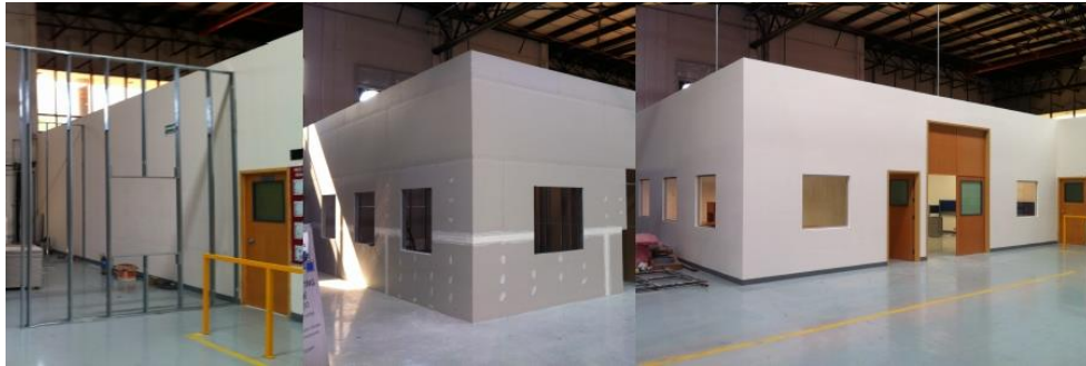
Ilustración 90. Ejemplo de construcción con tabla roca
