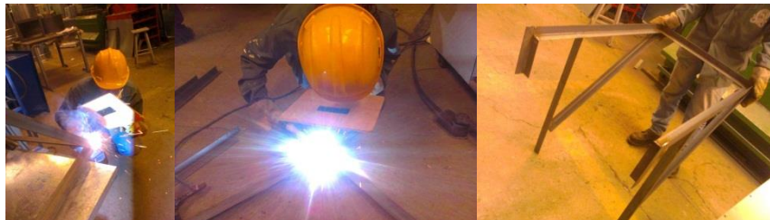
Ilustración 71-Proceso de soldadura y estructura finalizada(derecha).
