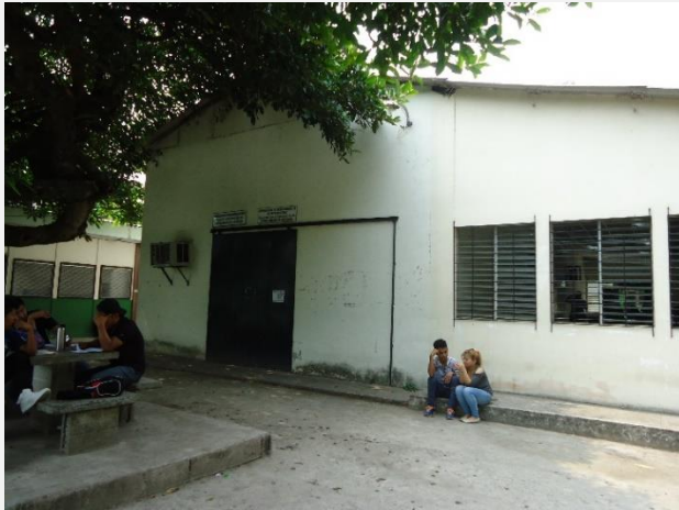
Fotografía N°7: vista de fachada norte-acceso principal.
