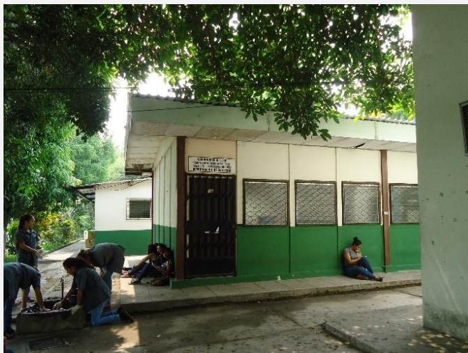
Fotografía n°8: vista de fachada poniente - acceso principal.
