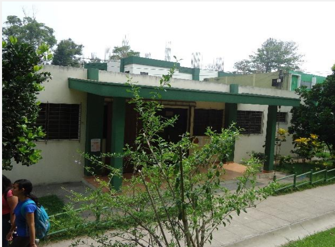
Fotografía N°6: vista de fachada sur-acceso principal.
