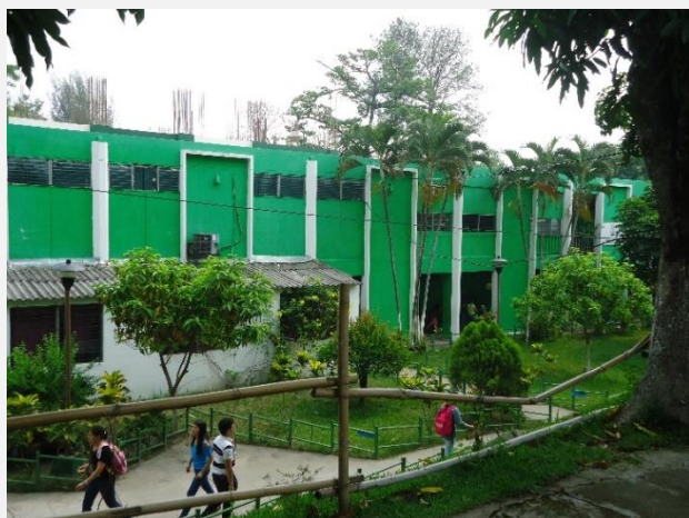
Fotografía N°11: Vista de fachada sur acceso principal.
