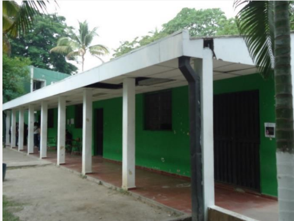
Fotografía N°12: Vista de fachada sur acceso principal.
