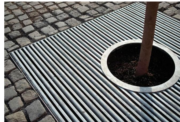
Fotografía N°219: alcorque para arboles grandes
