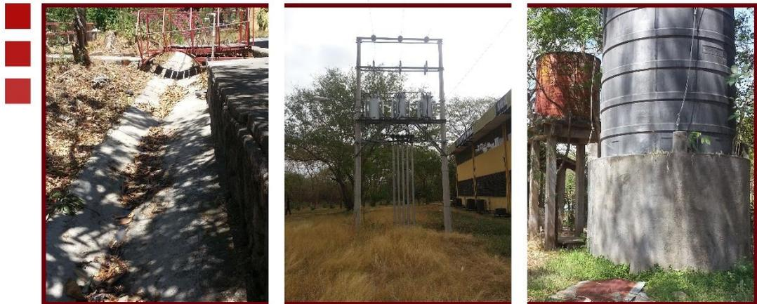
Imagen n° 39 Instalaciones Eléctricas e Hidráulicas: Canaleta de Aguas Lluvias, Transformadores, Tanques.
