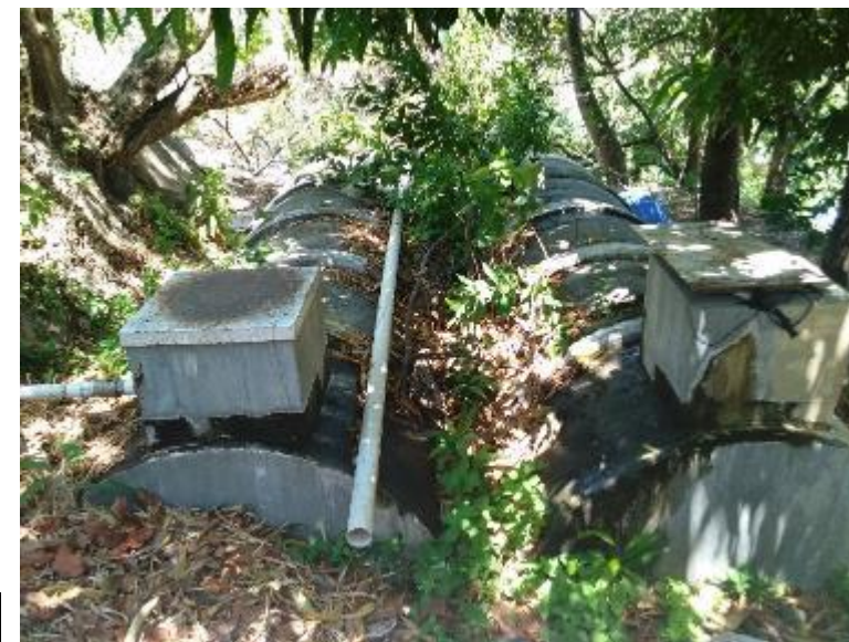
Fotografía 2: Tanques de agua potable de concreto reforzado ubicado cerca del acceso a la zona del Despacho Ministerial
