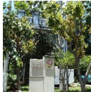
Fotografía 1: en cercanías de calle principal sector 1
