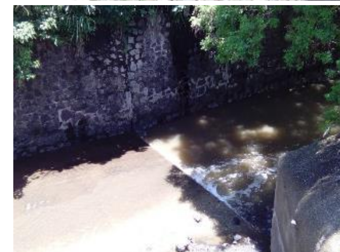
Fotografía 2: Las crecidas en temporales de la Quebrada La Lechuza pueden provocar inundaciones y /o
