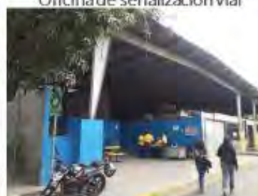
Bodega de bacheo
