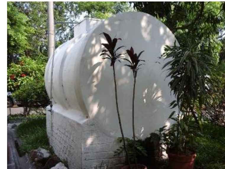
Fotografía 1: Tanque de agua potable apoyado sobre el suelo o de superficie, de base de ladrillo y material exterior de concreto reforzado.
