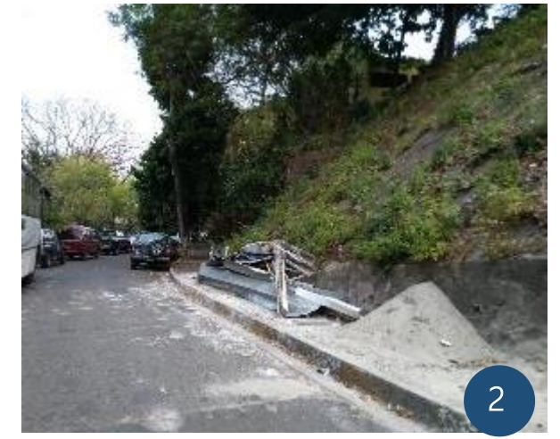
Imagen 5: Talud área de Viceministerio de Vivienda y Desarrollo Urbano
