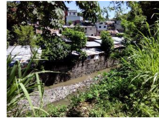
Fotografía 1: Ubicada en el plano, se identifica en éste sector problemas de inestabilidad de terreno por derrumbes y erosiones
