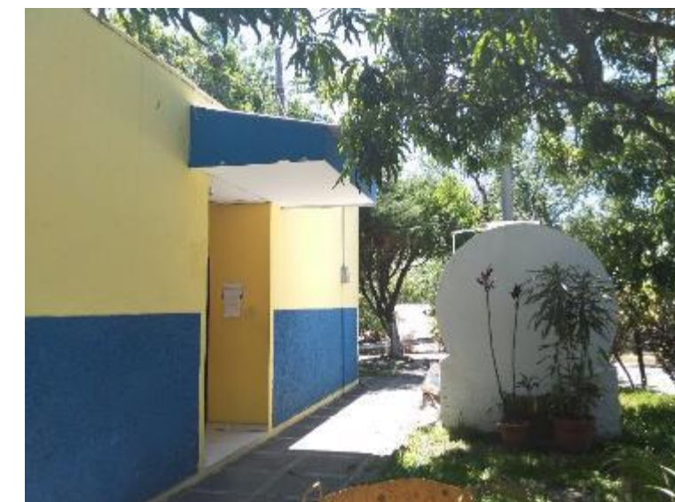
Fotografía 2: Cisterna de agua potable ubicada en la zona exterior de los servicios sanitarios de la Unidad Financiera Institucional – sector 1
