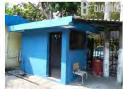
Caseta de seguridad
