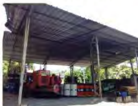
Bodega de grava y maquinaria
