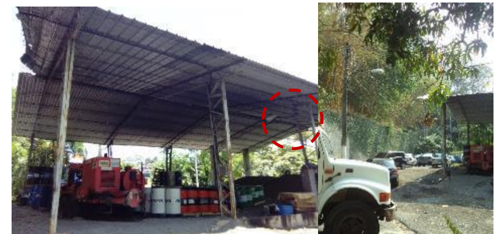
Fotografía 2: Tipología de luminaria existente adosada a la estructura de la galería, tipo bandera y múltiple en sector 3
