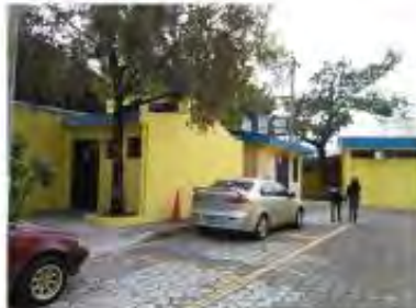
S.S., PNUD, Subestación eléctrica
