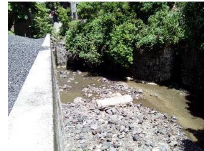
Fotografía 1: Quebrada La Lechuza.
