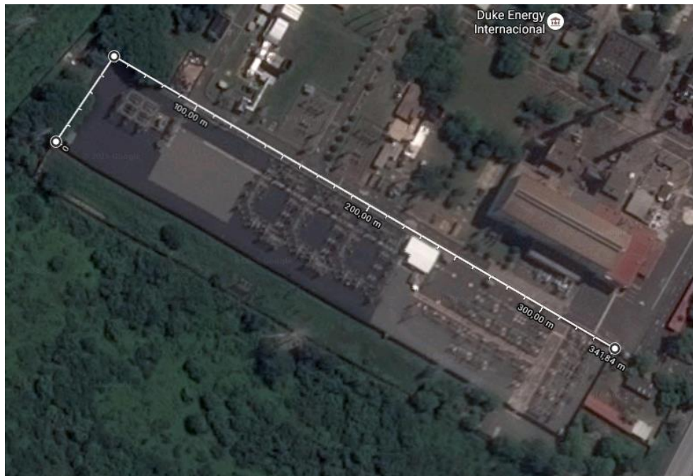
Figura 23 Vista aérea de la subestación de Acajutla tomada de "google maps".
