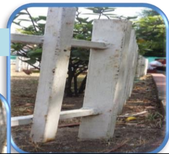
Fotografía de Estado actual de Barandales.
