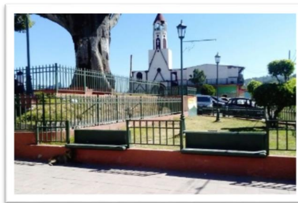
Imagen 14: Bancas de Concreto, sin protección de luz solar, frente a fachada principal de Alcaldía Municipal
