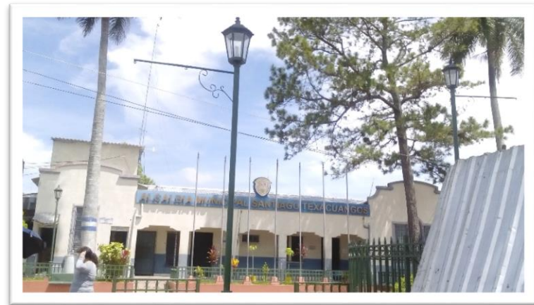
Imagen 16: Fachada Principal de la Alcaldía Municipal de Santiago Texacuangos
