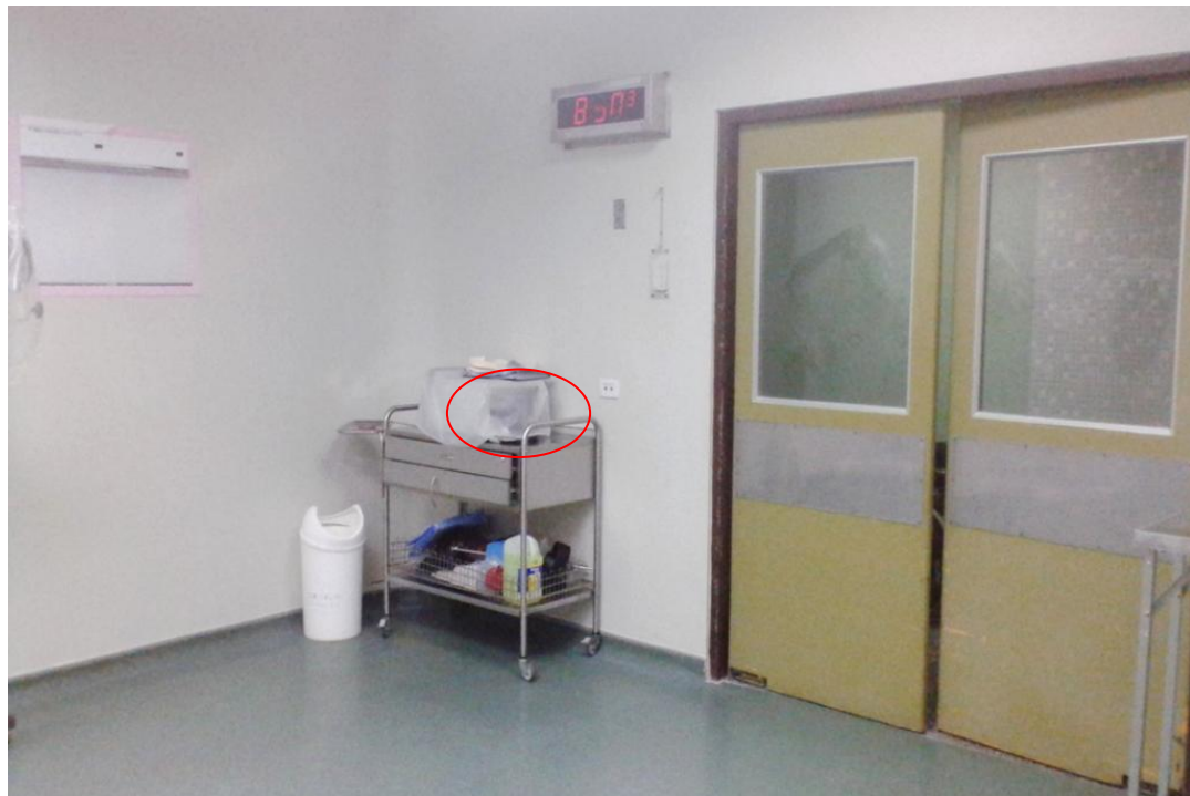
Figura Nº 6 entrada y salida del Quirófano
