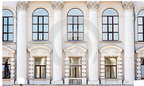
Imagen 21: Arcos de medios puntos en puertas y ventanas
