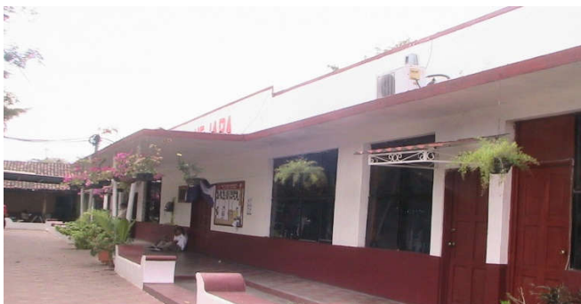
Fotografía 6: Fachada Principal del Edificio Municipal Frente al Parque Municipal Fuente: Toma Fotográfica Propia
