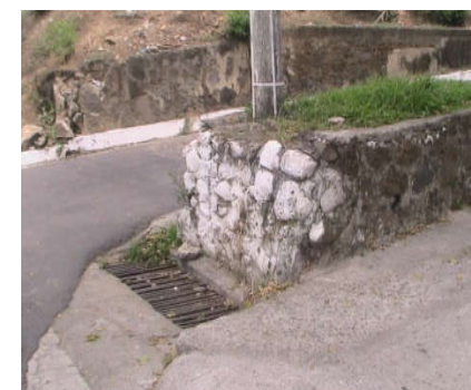
Fotografía 29: Parrilla de Caja Tragante de A. LI. en Ave. Eliseo Mijango Fuente: Toma Fotográfica Propia.
