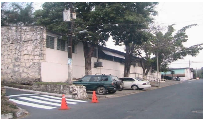
Fotografía 8: Fachada posterior del Edificio Municipal a la Avenida Eliseo Mijango Fuente: Toma Fotográfica Propia
