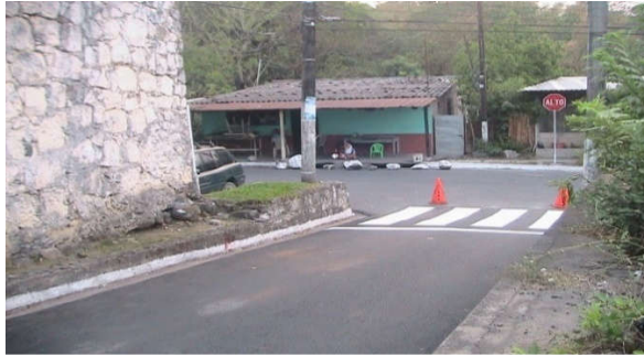
Fotografía 10: Desnivel en fachada lateral del Edificio Municipal en 1° calle Poniente Fuente: Toma Fotográfica Propia
