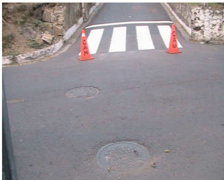
Fotografía 22: Pozo de A.LL. Pozo de A.N. en Avenida Eliseo Mijango Fuente: Toma Fotográfica Propia
