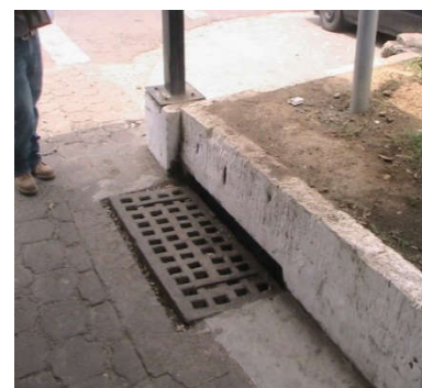
Fotografía 28: Parrilla de Caja Tragante de A.LL. 3° calle Poniente Fuente: Toma Fotográfica Propia
