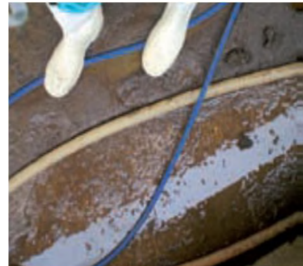
IMAGEN 2: RIESGO DE DESLIZAMIENTO POR FALTA DE LIMPIEZA.
