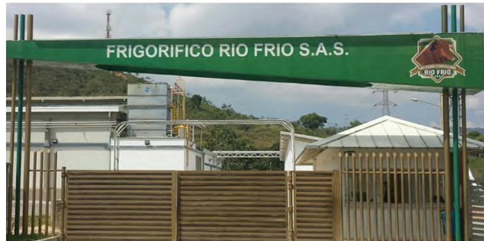
IMAGEN 36: ACCESO VEHICULAR Y PEATONAL DE FRIGORÍFICO RIO FRIO S.A.S SANTANDER, COLOMBIA.
