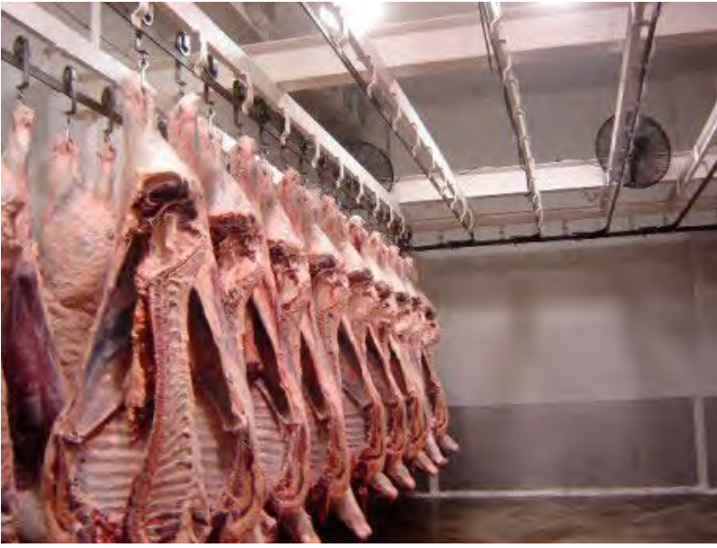
IMAGEN 34 : VISTA DE CAMARA FRIGORÍFICA DEL RASTRO MUNICIPAL DE TORREÓN, MÉXICO.
