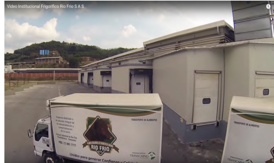
IMAGEN 40: CARGA DE CANALES EN FRIGORIFICO RIO FRIO S.A.S. , SANTANDER, COLOMBIA.
