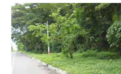
J CARRETERA DEL LITORAL CA-2 Y POSTES DE ENERGÍA ELÉCTRICA.
