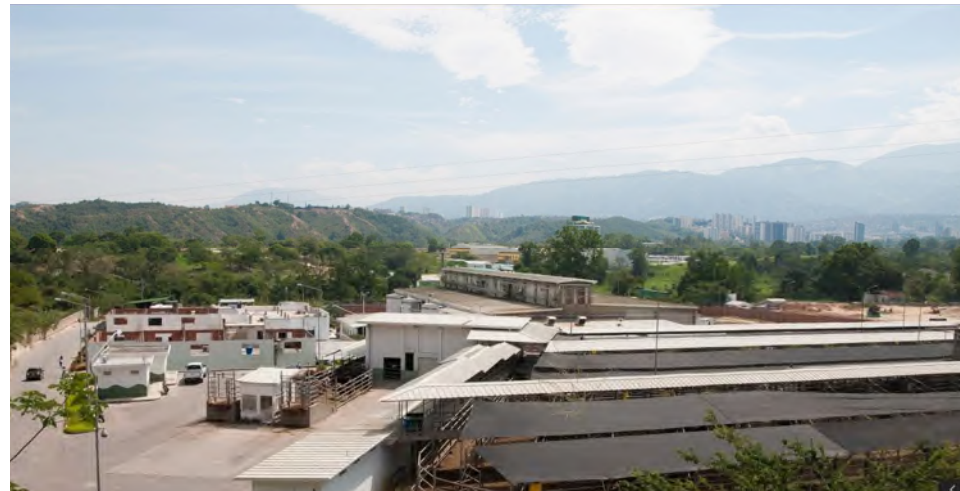
IMAGEN 37: VISTA EXTERIOR DE FRIGORÍFICO RIO FRIO S.A.S. SANTANDER, COLOMBIA.
