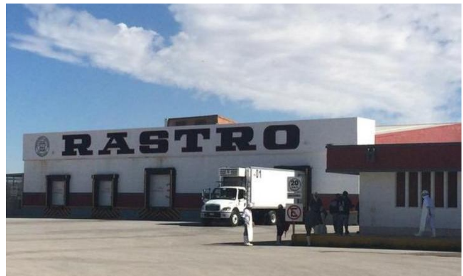
IMAGEN 30: VISTA SUR DEL RASTRO MUNICIPAL DE TORREÓN, MÉXICO.
