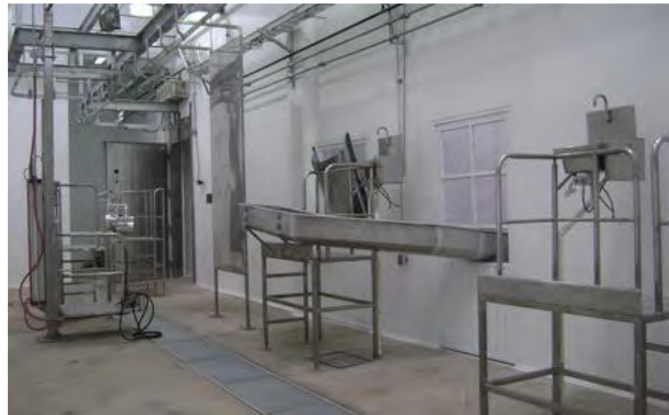
IMAGEN 35 : VISTA INTERIOR DEL RASTRO MUNICIPAL DE TORREÓN, MÉXICO.
