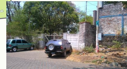
1 IMAGEN 49: Postes de suministro eléctrico existente
