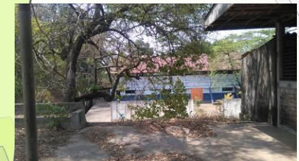
4 VISTA N°4 CANCHAS DEL INSTITUTO NACIONAL DE USULUTÁN
