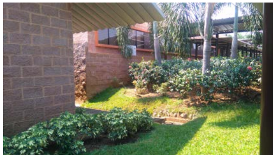
IMAGEN 60: Taludes con vegetación baja y alta
