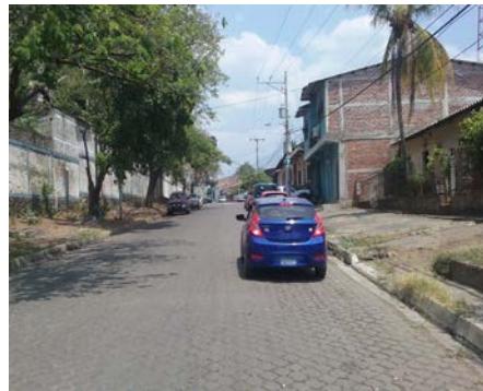
IMAGEN 34: Calle el Molino, calle adoquinada en buen estado.
