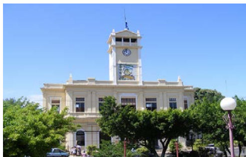
IMAGEN 8: Fachada principal de la Alcaldía de Usulután
