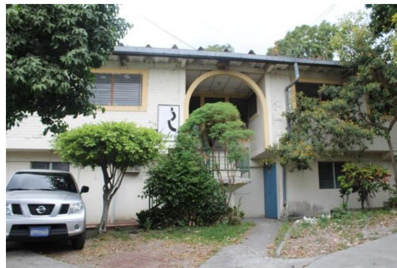
Imagen 16: Fachada Este, Edificio Actual de PODES
