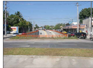
Vista de la zona norte del paso a desnivel y Boulevard Constitución
