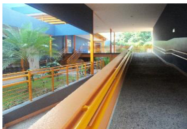
Imagen 18: Rampa al interior de FUNTER
