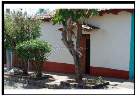
IMAGEN N° 9 Casa de adobe con fachada sencilla sobre 4ª av. Sur Barrió La Cruz.
