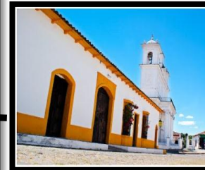
img.34 Casa de la abuela
