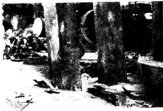
Foto 10. Beneficio «San José». Máquina pesada que fué levantada y que al caer rompió los ladrillos de su fundamento.
