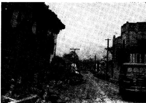
Foto 3. Chinameca. Vista al norte; la casa del sistema mixto quedó en pie; la de adobe se inclinó al oriente.
