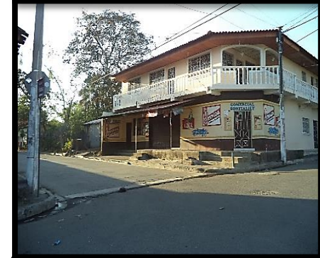
Mescla de técnicas de construcción
