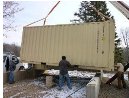
82. Colocación Del Contenedor Sobre Las Cimentaciones
