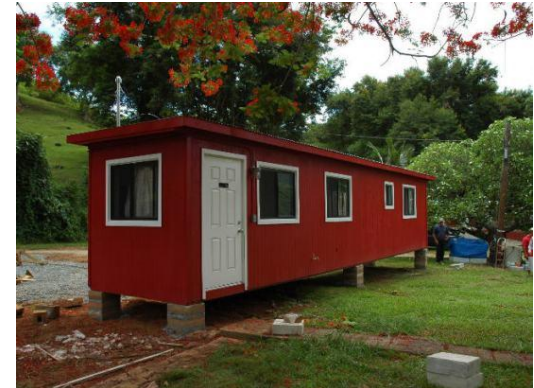
24. Vivienda permanente utilizando un contenedor de carga como estructura.
