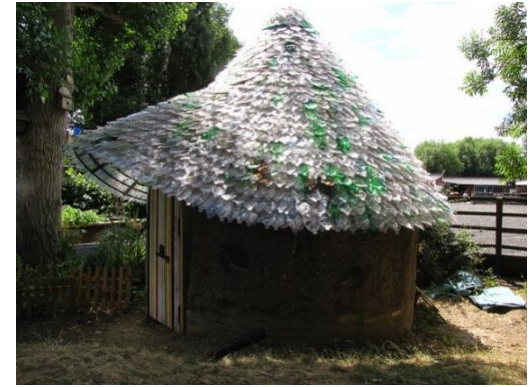
36. Casa con cubierta de techo mediante botellas plásticas, Honduras.
