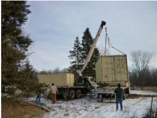
81. Elevación De Contenedor Mediante Grúa Hidráulica
