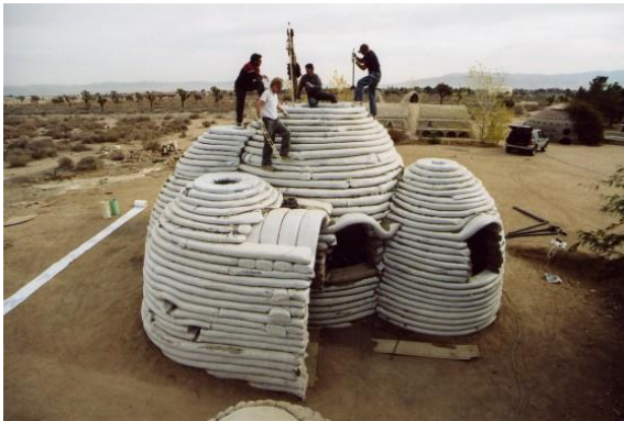
28. Casas de adobe con estructura de bolsas de tierra. Arq. Nader Khalili, USA.
