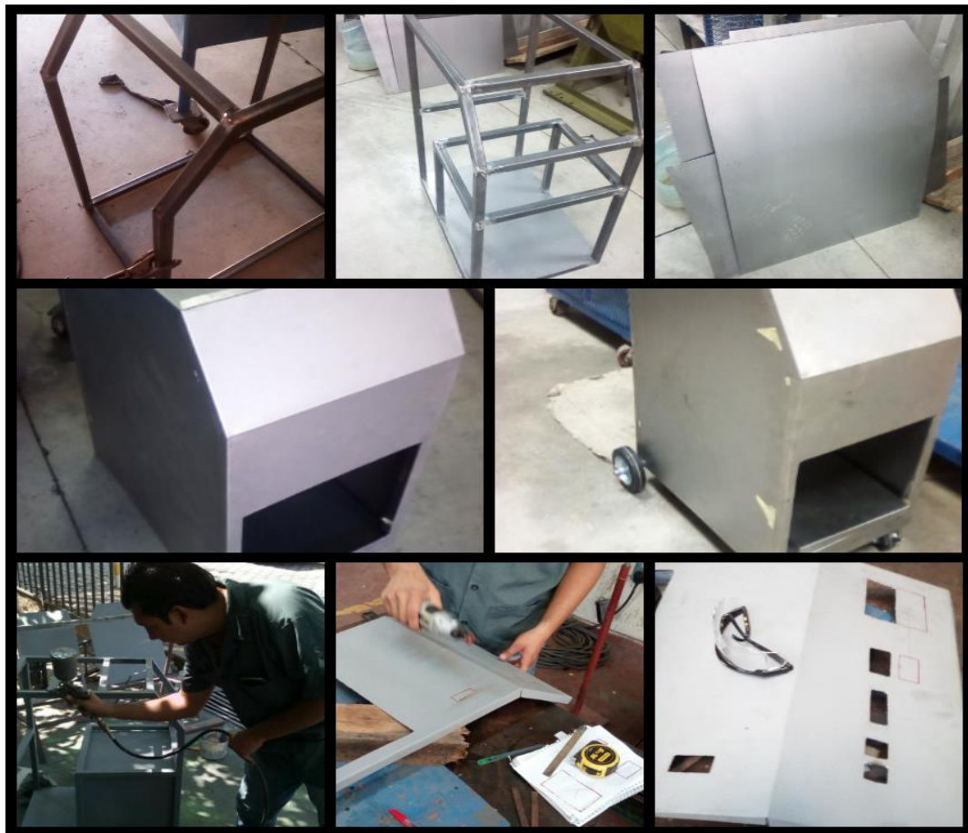
Figura 83. Construcción de estructura metálica
