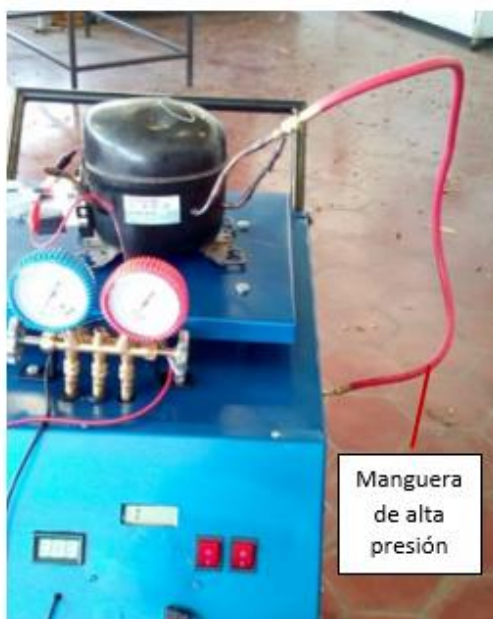
Figura 1. 6 realizando medición de presiones a la salida del compresor.
