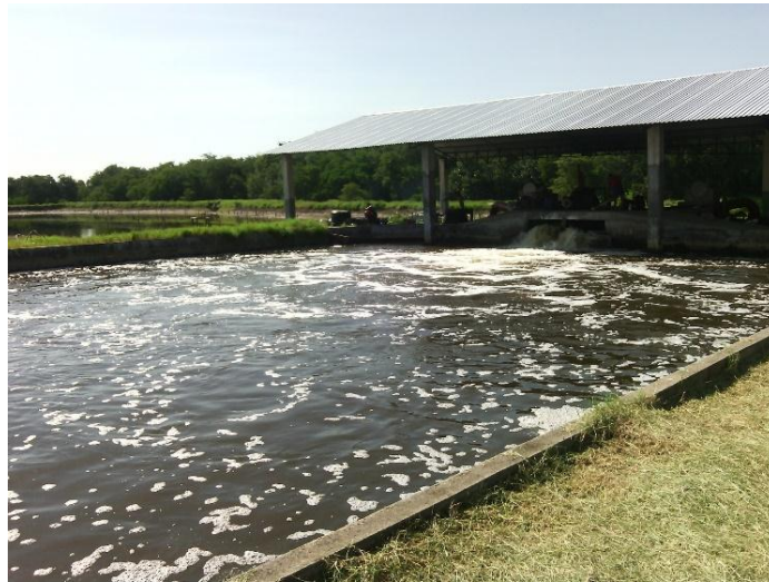
Figura A24. Estanque reservorio, entrada de agua y bomba de abastecimiento.
