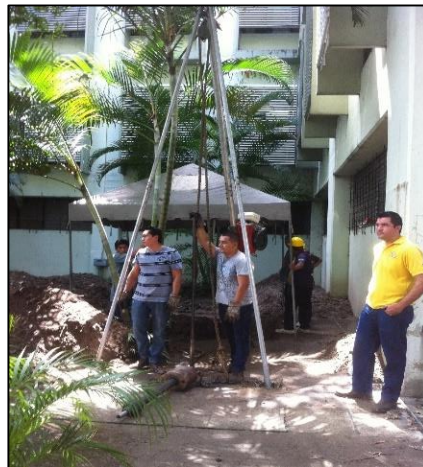
Figura IV-24: Ensayo SPT realizado en el costado poniente del edificio.
