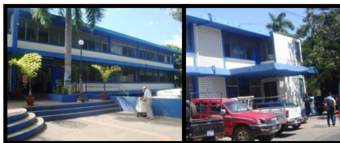
F-3.13. Entrada norte y sur de la Alcaldía Municipal. Fuente: propia
