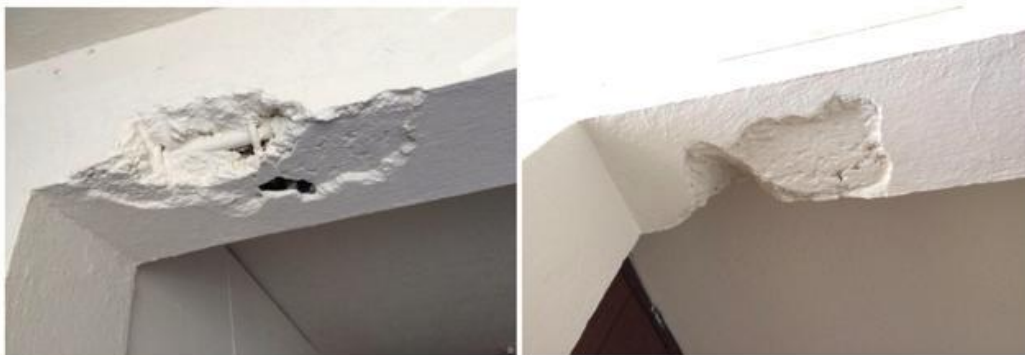
Daños en losas densa, grietas y acero expuesto, daños severo.
