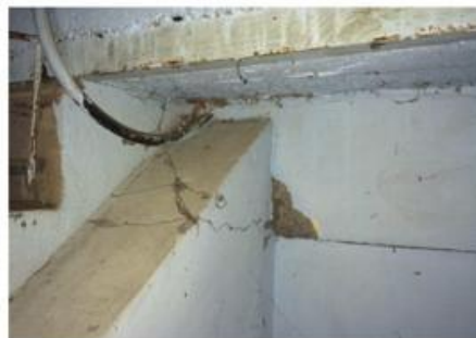
Detalle de condicion de columnas y muros, presencia de grietas
