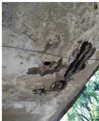
Detalle de condicion de columnas y muros, presencia de grietas
