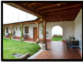
F-2.21. Corredores como protección del sobrecalentamiento Fuente: Seminario Taller Arquitectura Bioclimática Arq. Guillermo Altamirano
