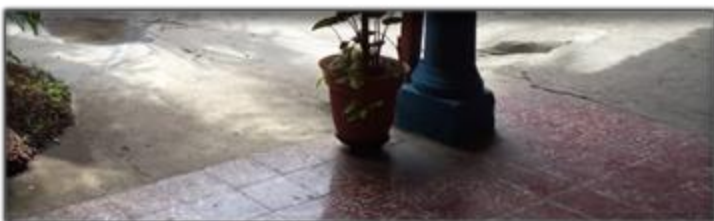
Imagen N°51: En cementado y suelo cemento que cubre en su mayoría el Colegio EICO.
