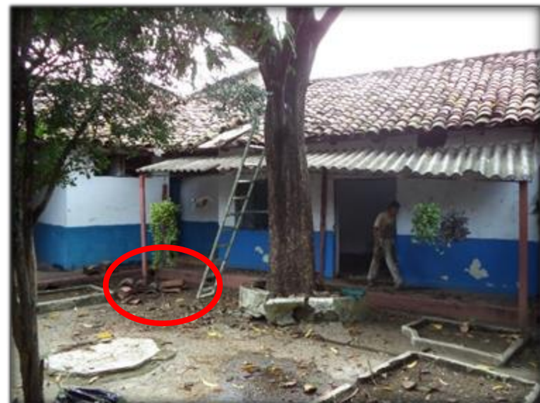
Imagen N°49: Tejado del Colegio EICO recibiendo mantenimiento, en el círculo rojo se observan las tejas que se pondrán sustituyendo a las dañadas.
