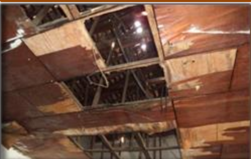
Imagen N°53: Estructura del Techo y Encielado.
