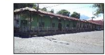
FOTOGRAFÍA DEL PORTAL PRUNERA
