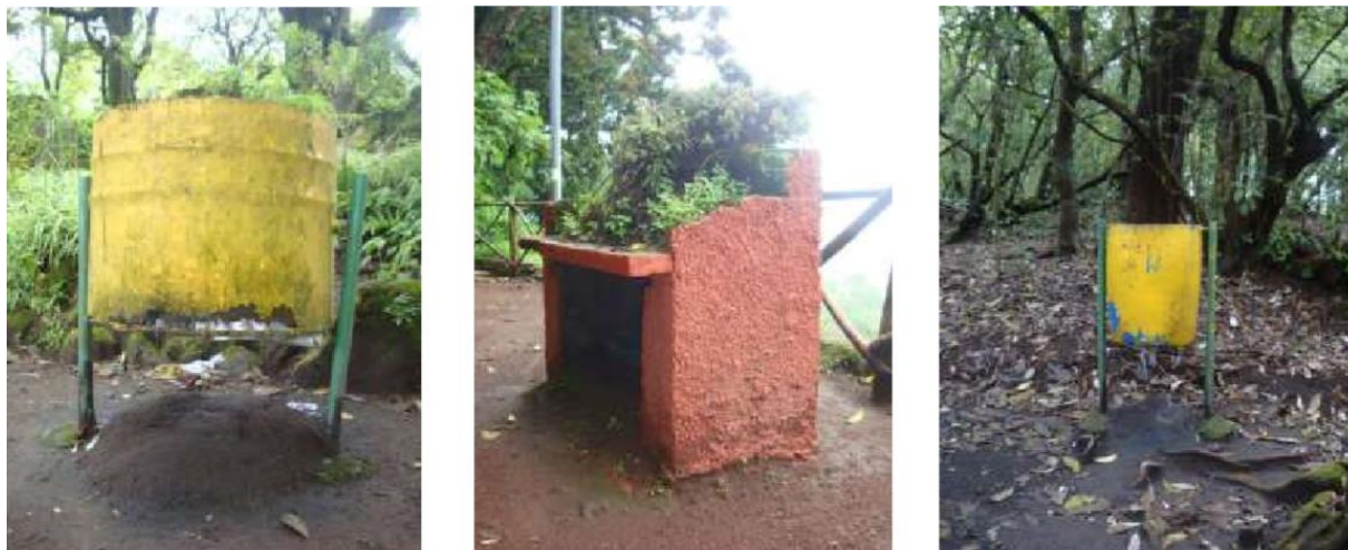
Imagen 30 - Deterioro de basureros y barbacoas
