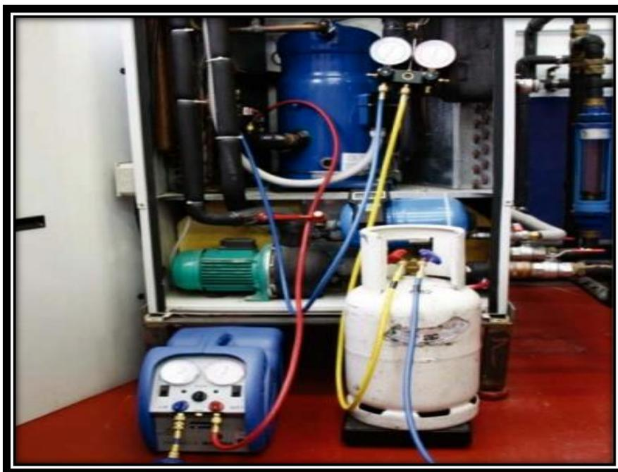
Figura 4-8: Recuperación de refrigerante mediante push-pull.
