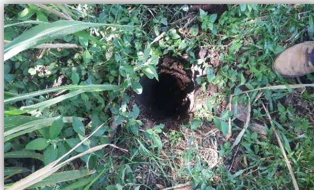
Figura 4.14 Excavación en zona de estudio para prueba de infiltración
