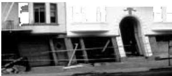
Figura 4.11: Ejemplo de edificios con inclinación.
