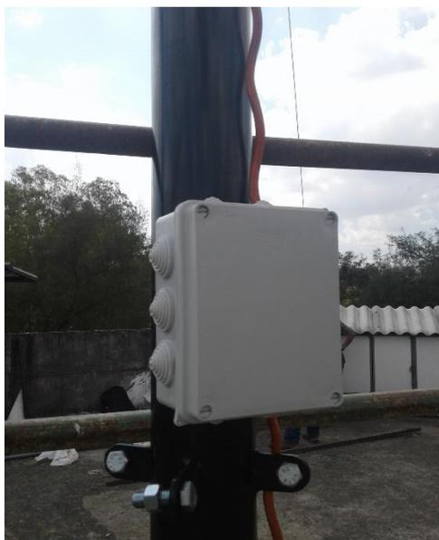
Figura 3.38 - Caja con bornera para pruebas.
