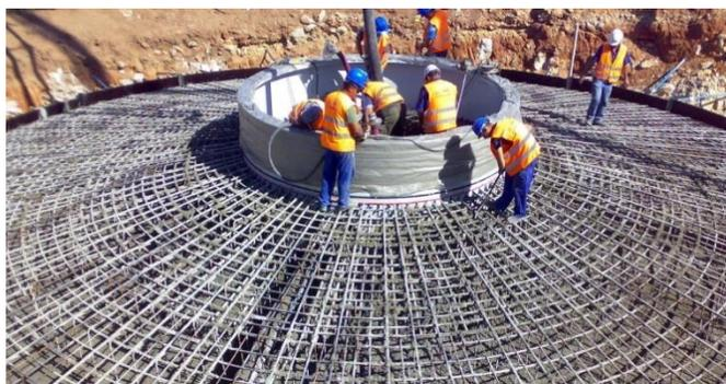
Figura 1.14 - Cimentación para torre de aerogenerador.
