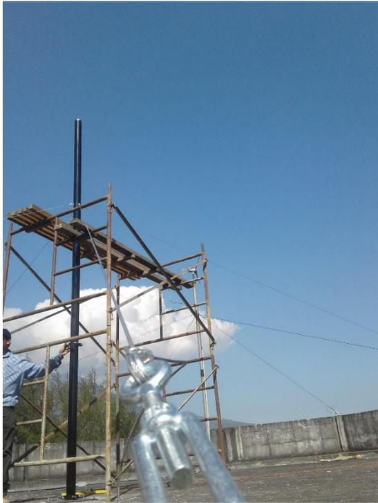
Figura 3.32 - Tensor y cable de la torre.
