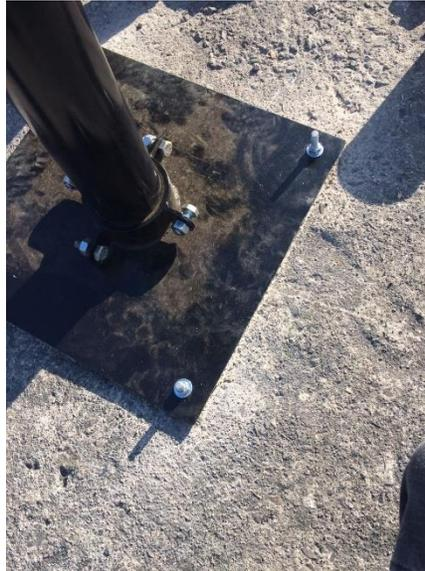
Figura 3.33 - Base de la torre y anclaje al piso.
