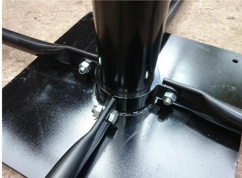
Figura 3.24 - Base de la torre con unión a los soportes horizontales.
