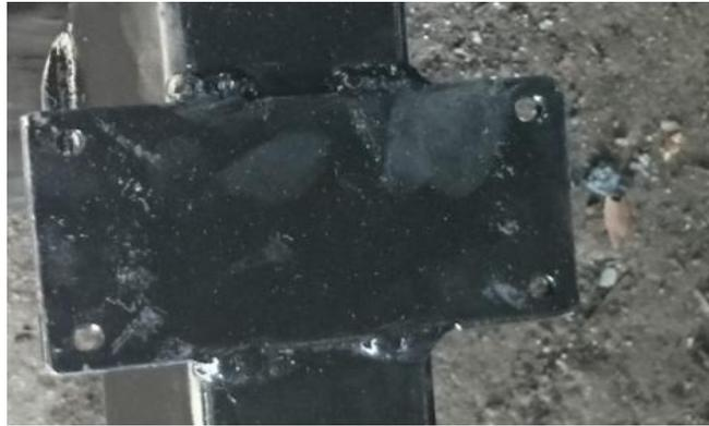
Figura 3.10 - Base para colocación del generador eléctrico.
