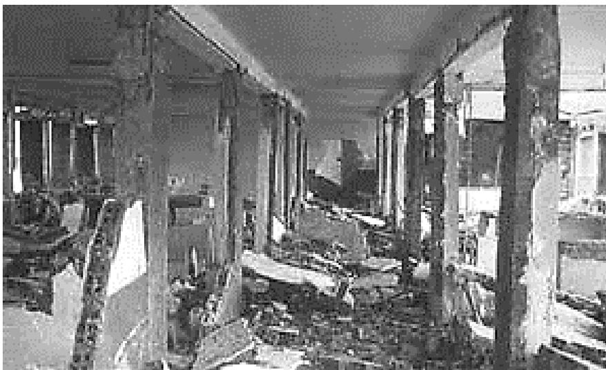
*Figura 2. 6: Colapso de paredes no estructurales (PAHO-OPS 1999)*
