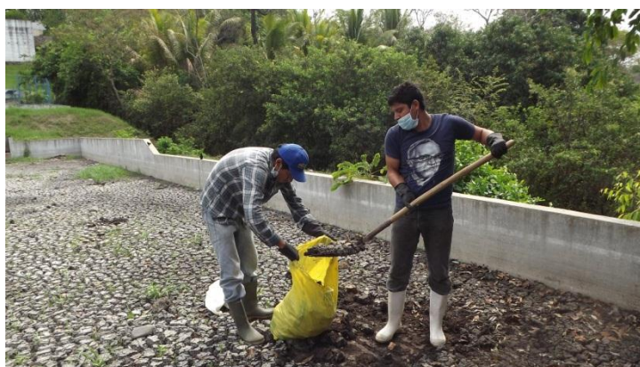
Figura 5. Llenado de sacos con lodos para posterior traslado a la EEP, UES.
