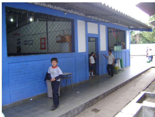
Instalaciones de los grados de primer ciclo de Educación Básica del Complejo Educativo Manuel Monedero
