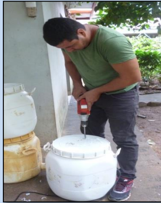
Perforación de tapadera de depósito
