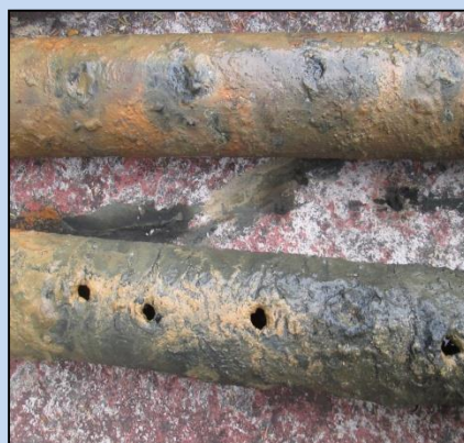
Lavado de tubería de la cruceta
