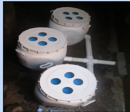
Instalación de filtro en tanque
