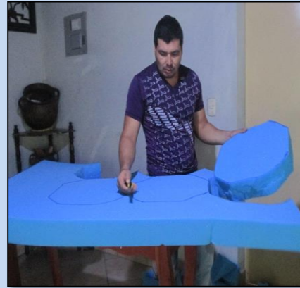
Corte de esponja para galería filtrante
