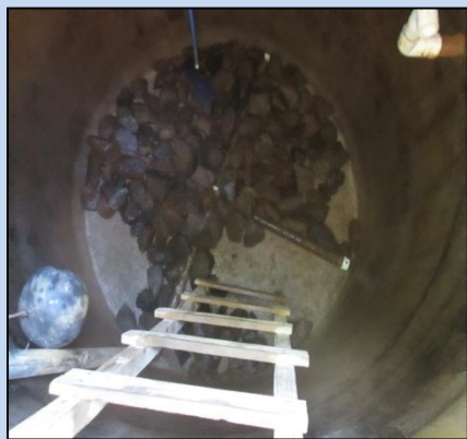
Instalación de piedra
