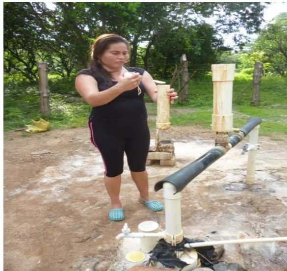
Figura 17. Fontanera aplicando cloro en dispositivo de cloración tipo T.
