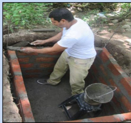
Construcción de broquel
