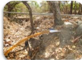
Purga de lodos antes de instalar el filtro de esponja
