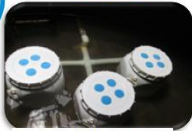
Instalación de filtro de esponja
