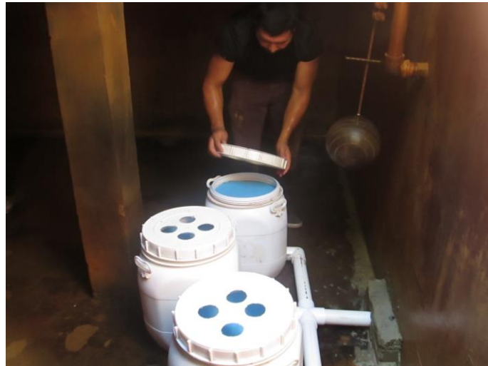
Figura 22. Instalación de filtro de esponja en tanque aireado – sedimentador.
