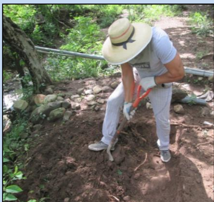
Trazo y excavación
