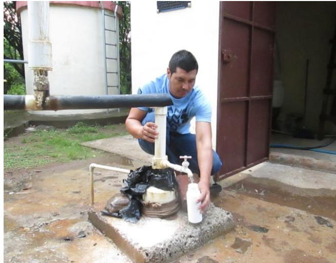
Figura 26. Toma de muestra agua en pozo
