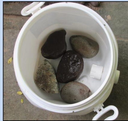
Instalación de piedras en filtro
