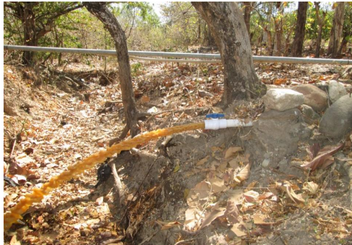
Figura 23. Muestra de agua en purga de lodos antes de instalar filtro de esponja y sedimentador.
