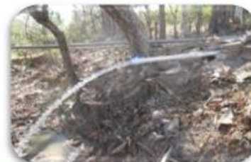
Purga de lodos después de instalar el filtro de esponja
