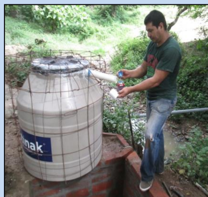
Instalación de accesorios pvc.
