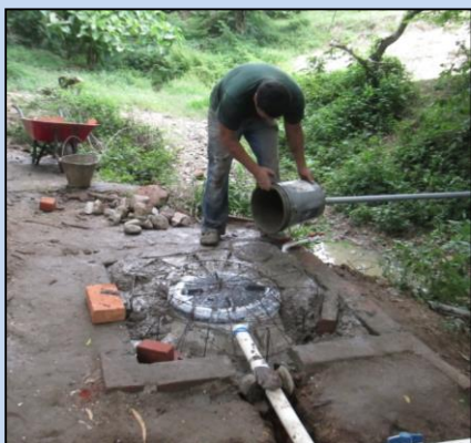
Fundido con concreto de tanque
