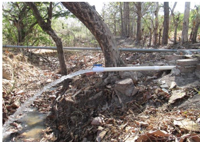
Figura 24. Muestra de agua en purga de lodos después de instalar filtro de esponja y sedimentador.
