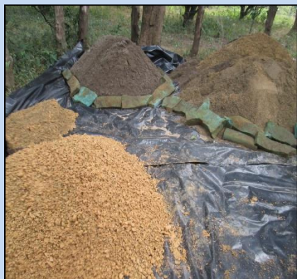
Extracción de arena del filtro
