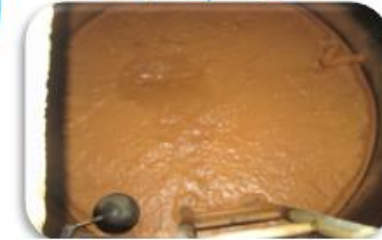
Filtro lento arena sin mantenimiento
