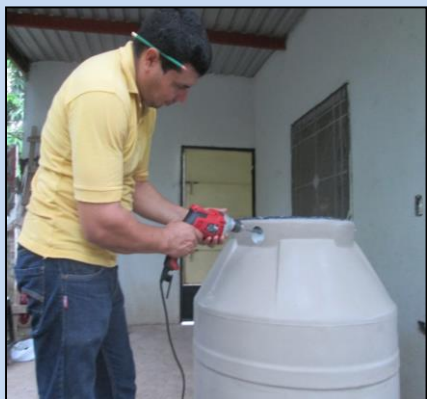
Perforación de orificios en tanque
