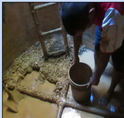
Descubriendo cruceta de tubería
