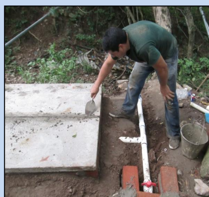
Sellado de tanque sedimentador
