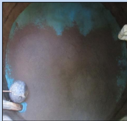
Instalación de capa esponja y llenado
