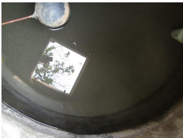
Figura 34. Filtro lento de arena después de las mejoras.
