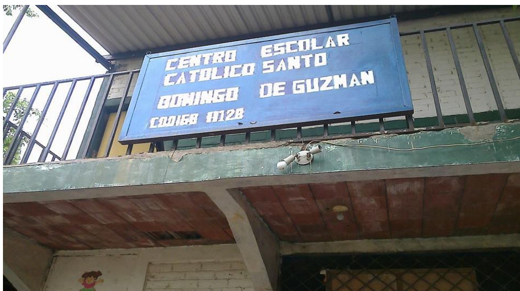
Ilustración 2. Fachada del C. E. Católico Santo Domingo de Guzmán
