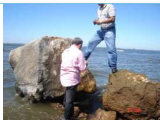
Foto 5: Inspección de los daños ocasionados en el lugar
