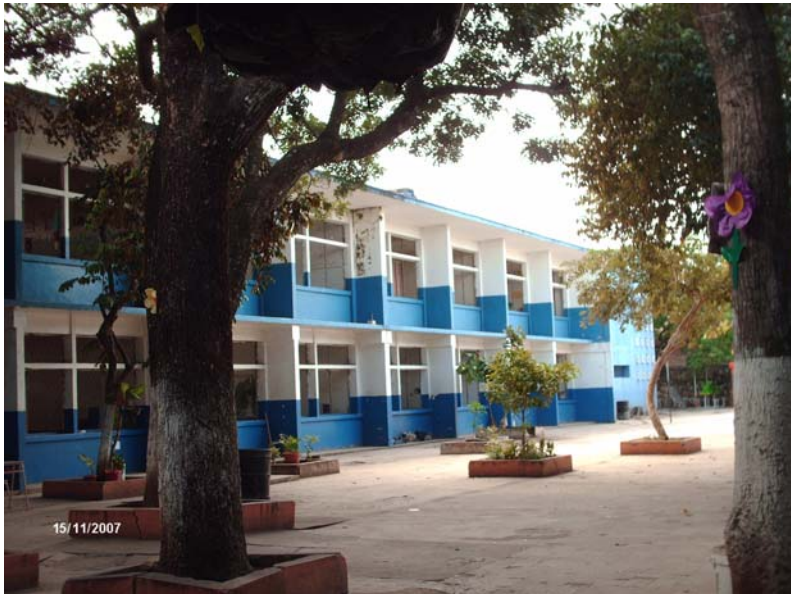
Fotografía No.6 Centro Escolar "Tomás Medina", Santa Ana– Octubre 2007
