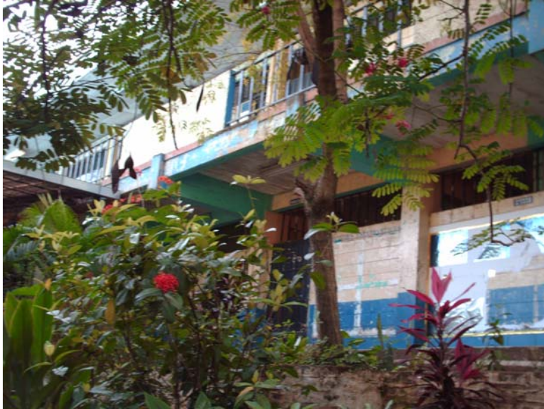
Fotografía No.5 Centro Escolar "Caserío El Carmen", Ahuachapán – Noviembre 2007
