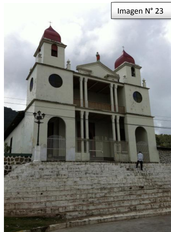
Fuente: Visita de campo. Fotografía del inmueble.
