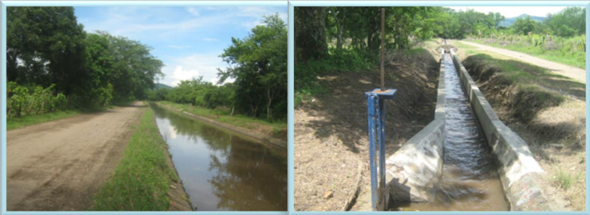
Figura 8: Canal principal y secundario de abastecimiento de agua.
