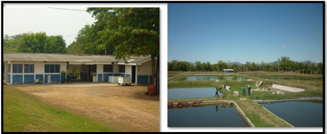
Figura 7: Instalaciones de la Estación Acuícola de Atiocoyo.
