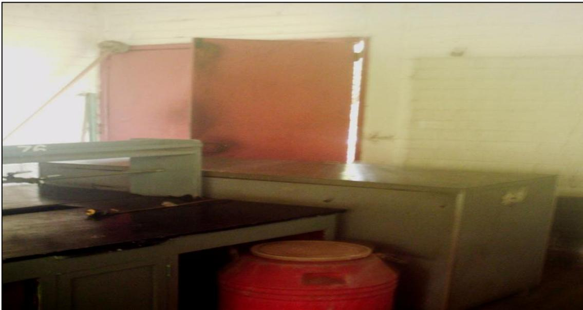
**Fotografía N° 4. Una de las salidas en el laboratorio N° 2 de Biología, aparece obstaculizadas por el espacio reducido interfiriendo con el paso libre quedando atrapado en una emergencia.**
