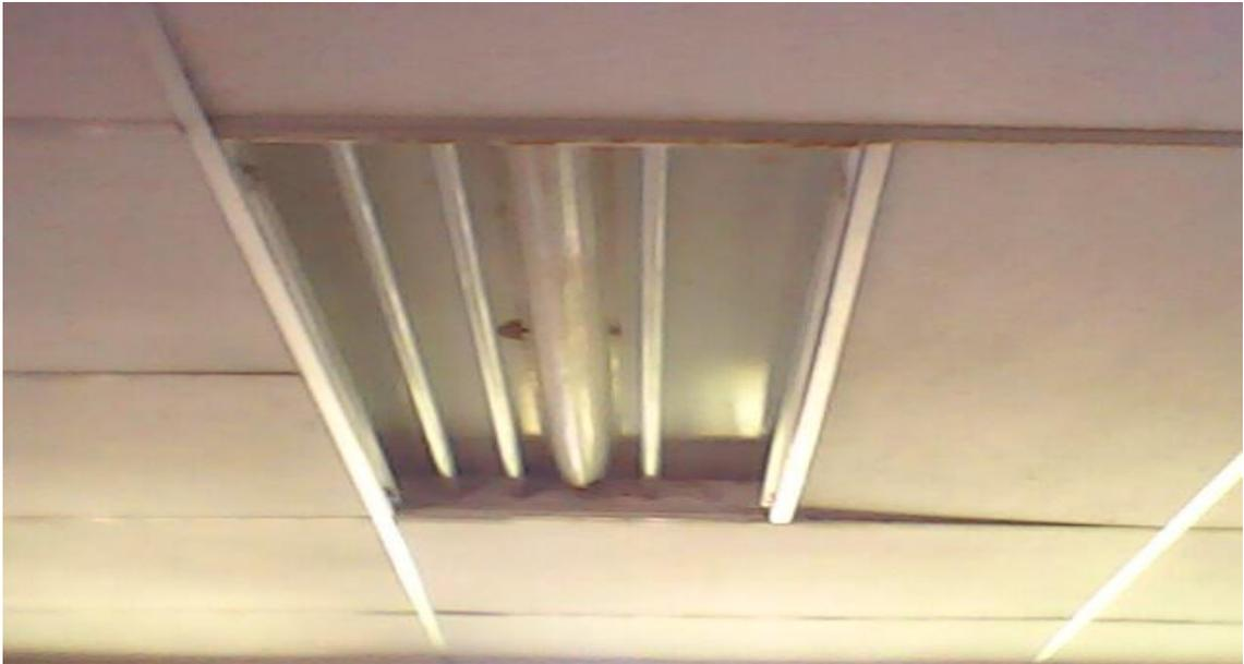
**Fotografía N° 1. Sistema de iluminación dentro de los laboratorios de Biología, Química y Física de la Facultad, sin ningún tipo de protección, generando peligro por desprendimiento de los tubos de iluminación.**
