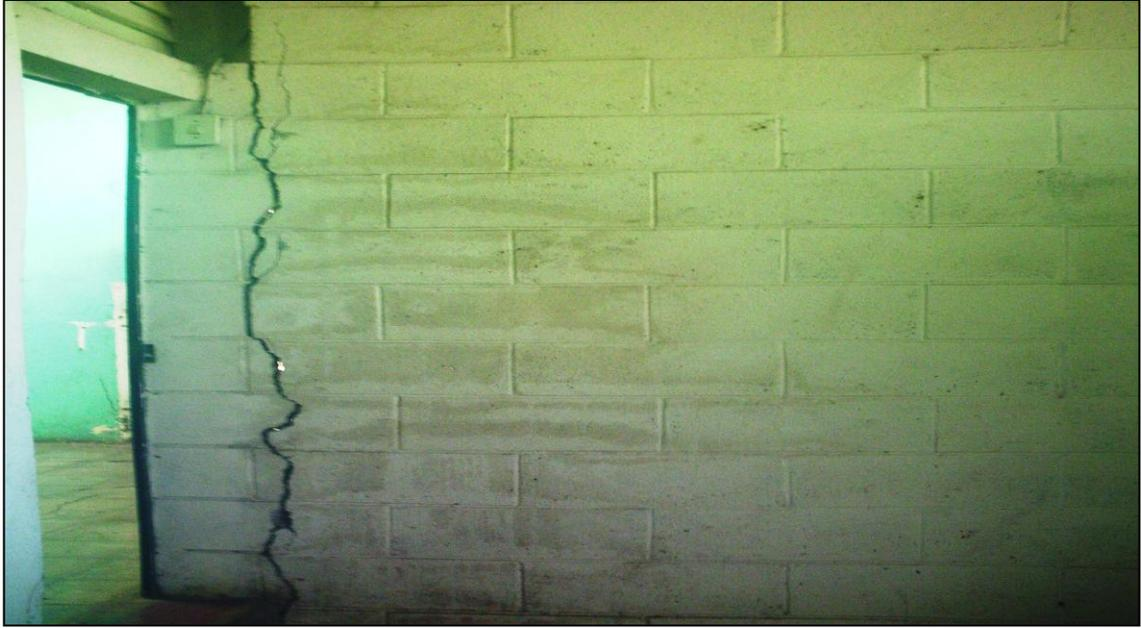
**Fotografía N° 9. Defecto de estructura en el Laboratorio 2 de Física, presentando fisuras en las paredes y desniveles de las mismas.**
