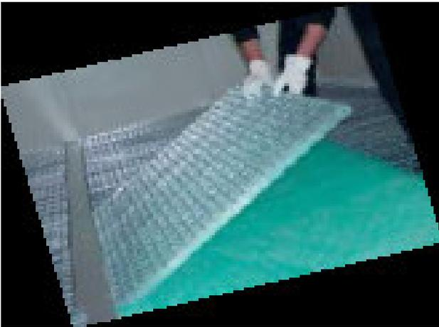
Foto # 1 Sustitución de los filtros de una cabina
