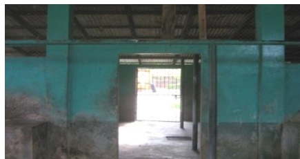
Figura No. 6 Parte interior del Rastro Municipal
