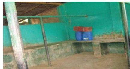
Figura No. 7 Parte interior del Rastro Municipal
