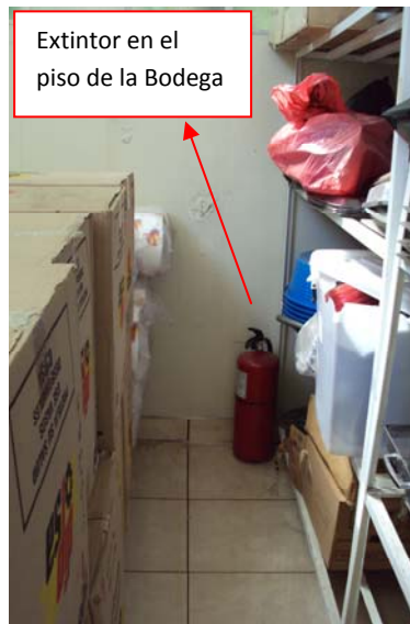
Imagen No.1.3 Ubicación de Extintor
